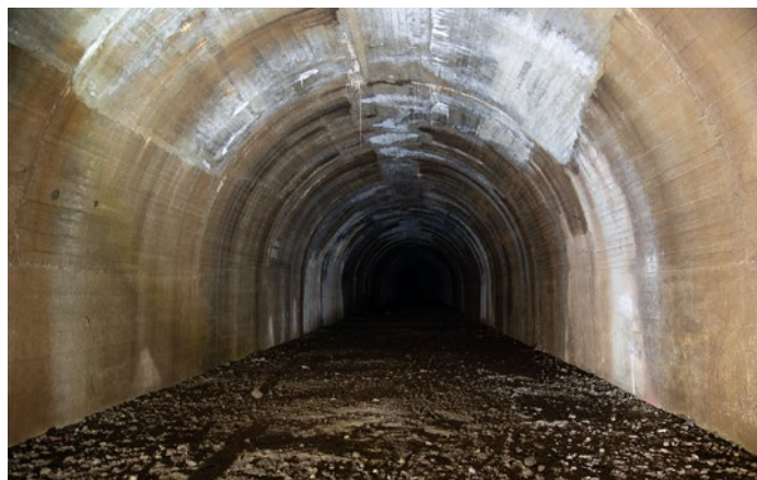
(Fig. 3) Un tratto della Galleria Rifugio fotografato prima che fosse interessato dal processo di riapertura e dai lavori di riqualificazione.
